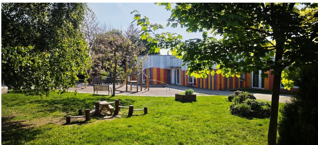
Obr. 24: Mateřská škola Moravany Zdroj: ENVIPARTNER, s.r.o. (2025)
